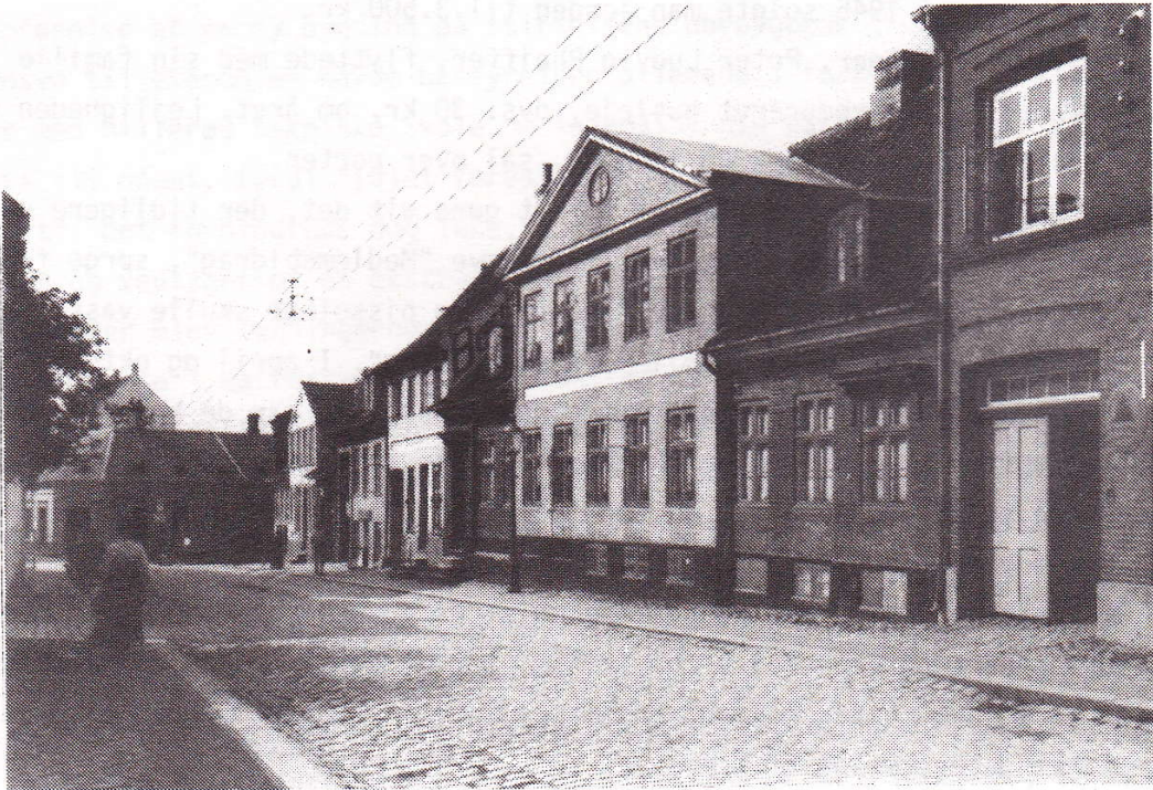
Borgerstiftelsen 1921. Bygningen til venstre med frontispice, også kaldet Forhuset, er bygget i empirestil. Til højre i billedet ses porten i den "nye" bygning fra 1883. Lejligheden over porten var den oprindelige portnerbolig.
